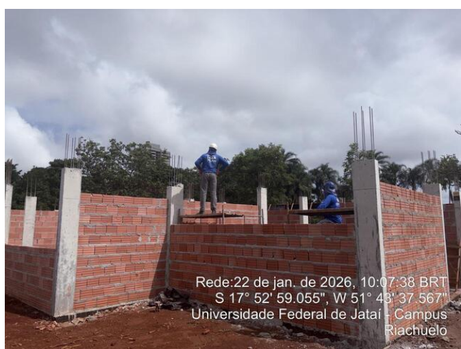
execução da alvenaria
