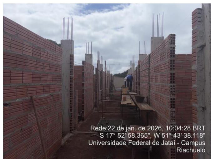
Execução da alvenaria
