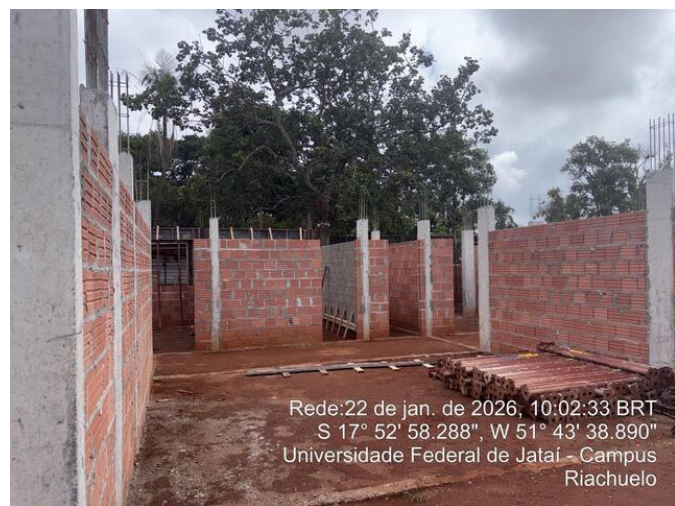
Execução da alvenaria
