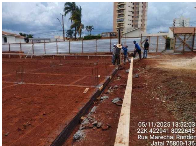
Montagem forma pilares
