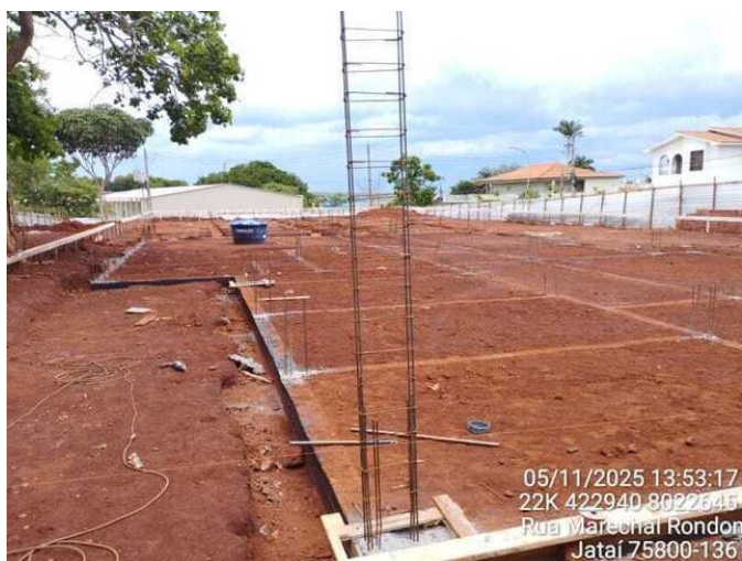
Montagem forma pilares
