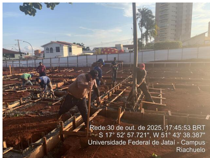
Concretagem da viga baldrame
