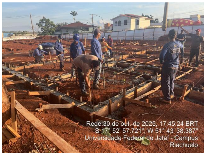
Concretagem da viga baldrame
