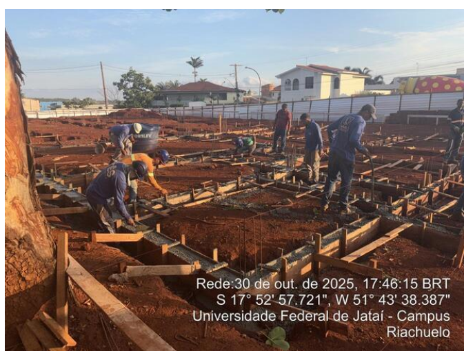
Concretagem da viga baldrame
