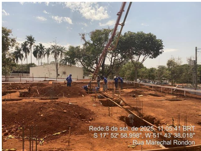
Concretagem das sapatas
