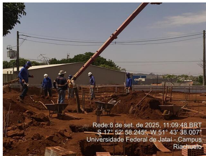
Concretagem das sapatas
