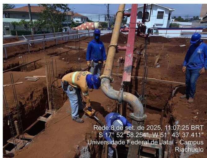
Concretagem das sapatas
