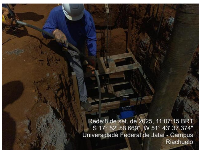
Concretagem das sapatas
