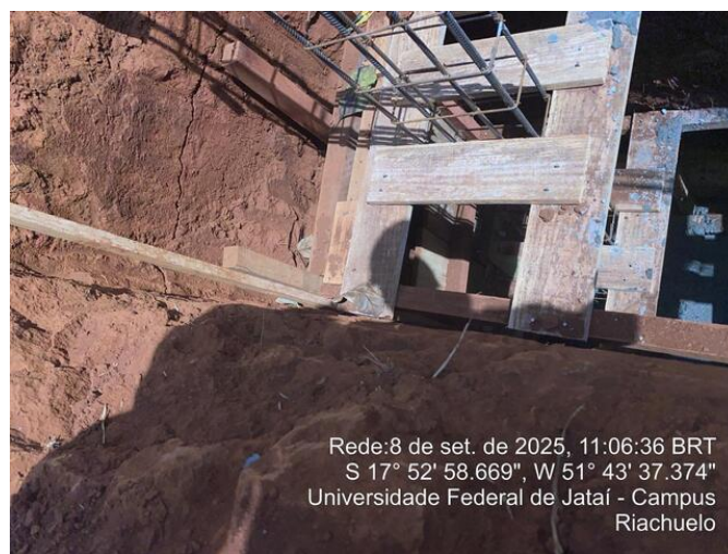
Concretagem das sapatas
