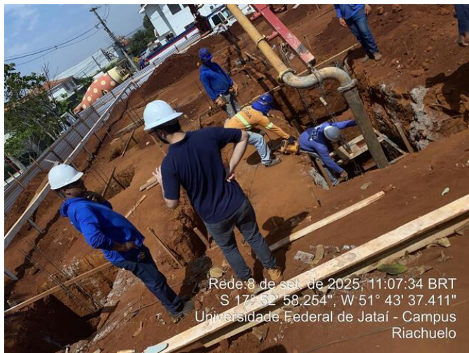
Concretagem das sapatas
