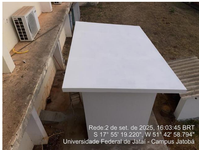
Pintura da Central de gás
