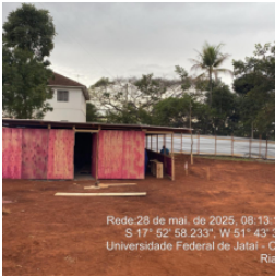
Barracão de obra
