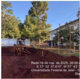
Corte e aterro do terreno.
