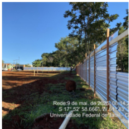
Instalação do tapume metálico.
