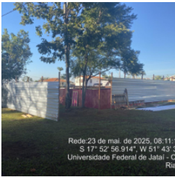
Tapume e barracão de obra.
