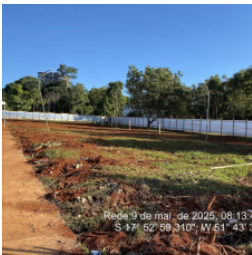
Instalação do tapume metálico.
