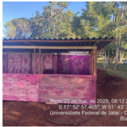
Tapume e barracão de obra.
