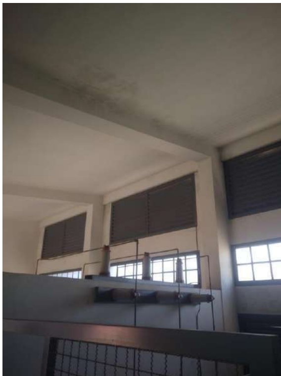
Figura 22: Telhado após manutenção.
