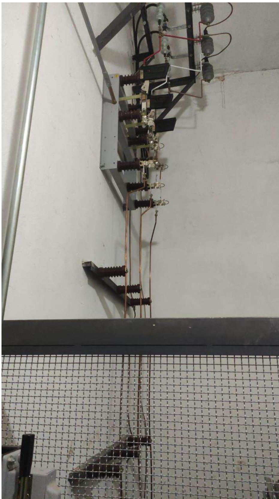
Figura 7: SE após limpeza e manutenção.
