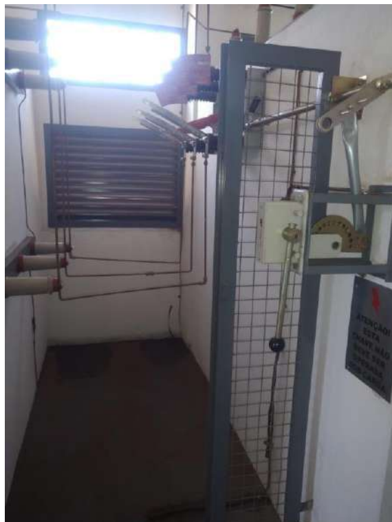
Figura 20: Baia chave seccionadora após limpeza e manutenção.
