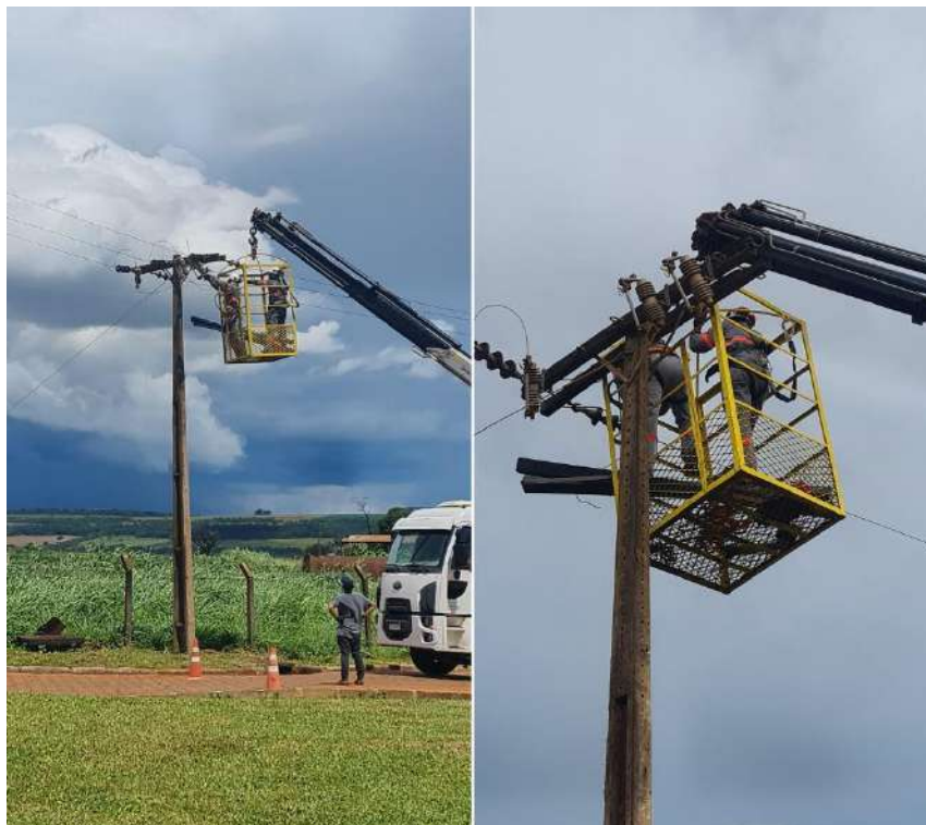
Figura 7: Execução das atividades em altura (NR35).
