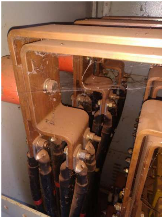
Figura 5: Painel / Barramentos gerador secundário antes da limpeza e manutenção.
