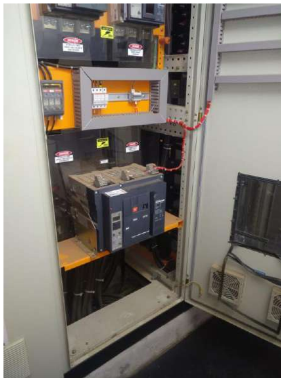
Figura 1: Disjuntor geral CCM antes da limpeza e manutenção.
