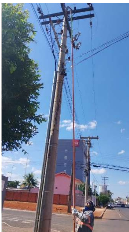
Figura 27: Fechamentos de chaves após serviço realizado.
