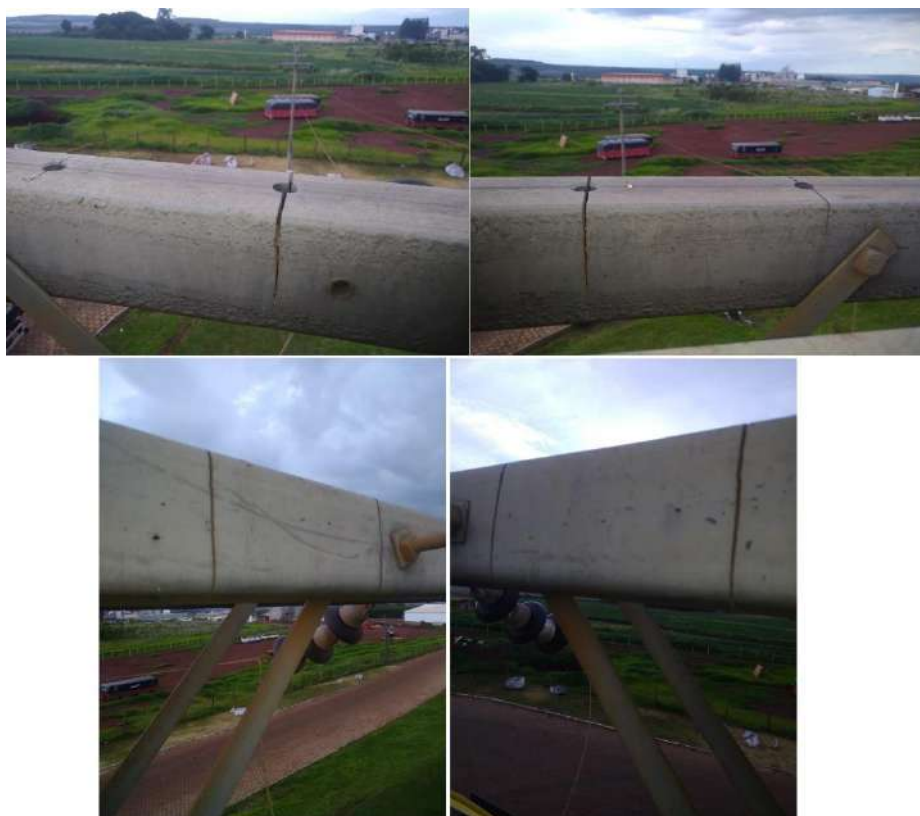
Figura 10: Detalhes cruzetas trincadas.
