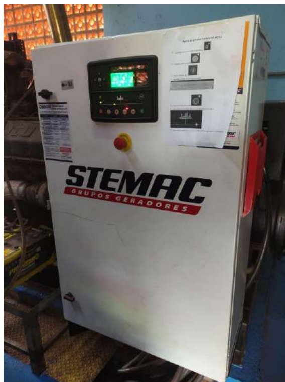
Figura 9: Painel de transferência de carga após limpeza e manutenção.
