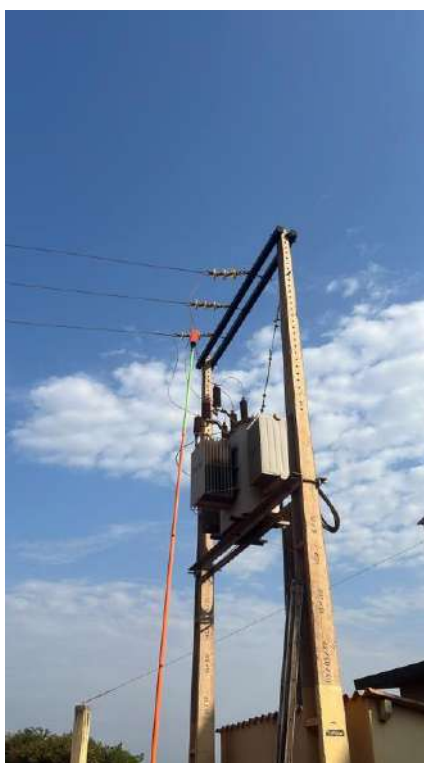
Figura 2: Detecção de tensão, conforme NR10.
