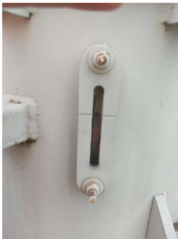
Figura 17: Nível baixo do TR 750 kVA foi ajustado.
