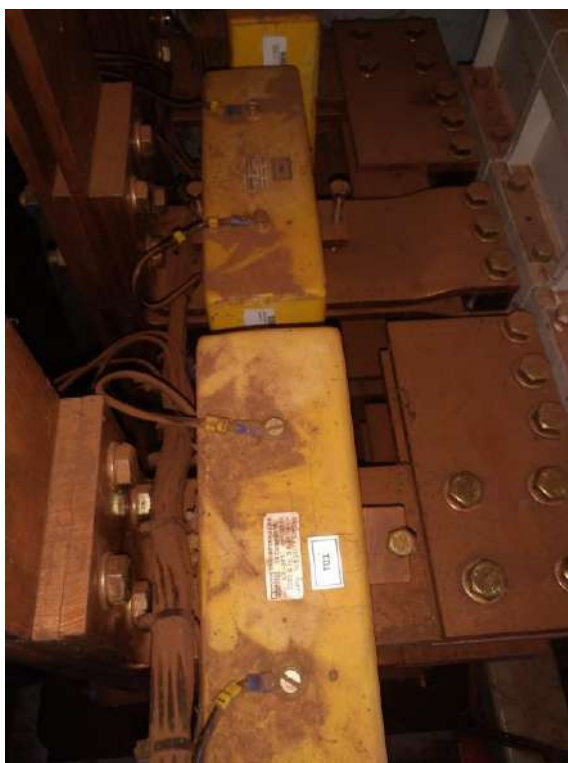
Figura 6: Barramentos painel gerador secundário antes da limpeza e manutenção.
