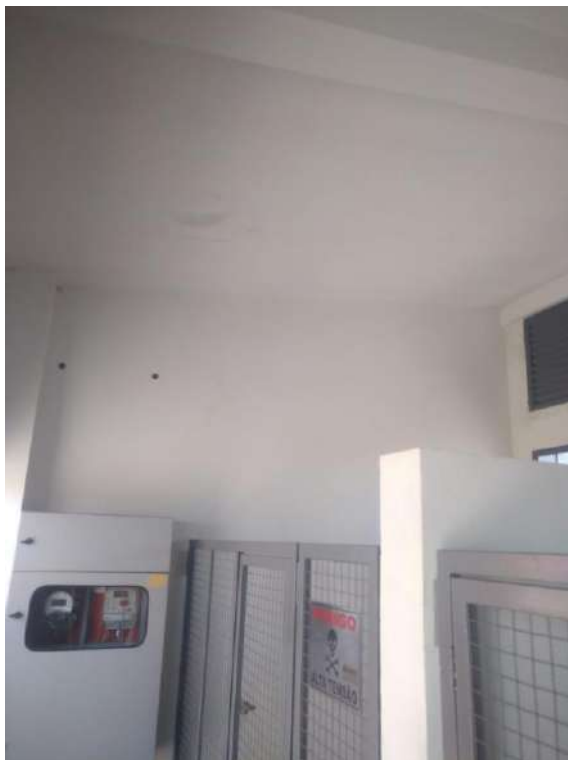
Figura 24: Paredes laterais e telhado após limpeza.
