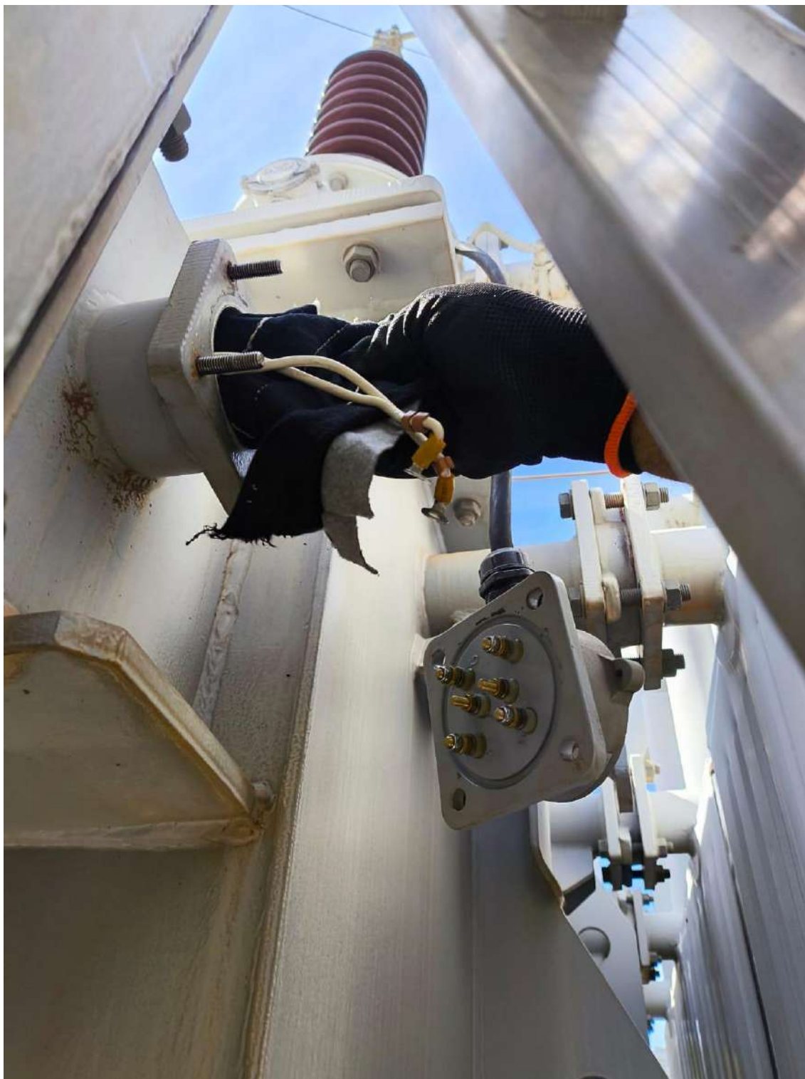
Figura 6: Serviço de troca de vedação em sensor de temperatura, Trafo WEG 18 MVA.
