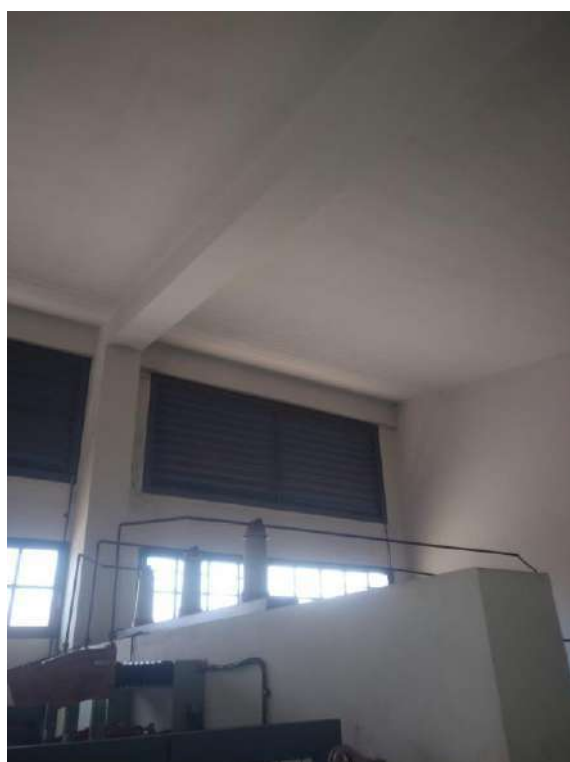
Figura 21: Telhado após limpeza.
