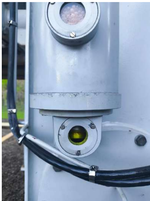
Figura 7: Sílica gel contaminada.
