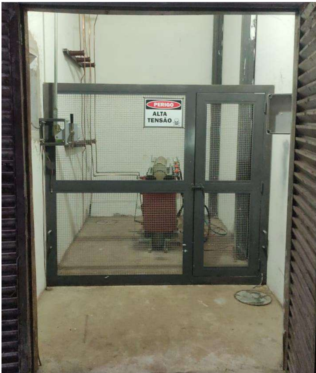
Figura 8: SE após limpeza e manutenção.
