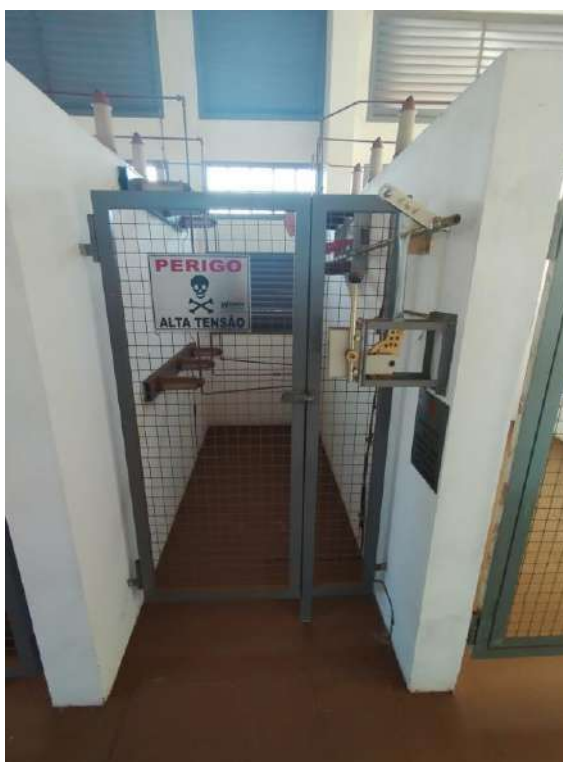
Figura 3: Chave seccionadora.
