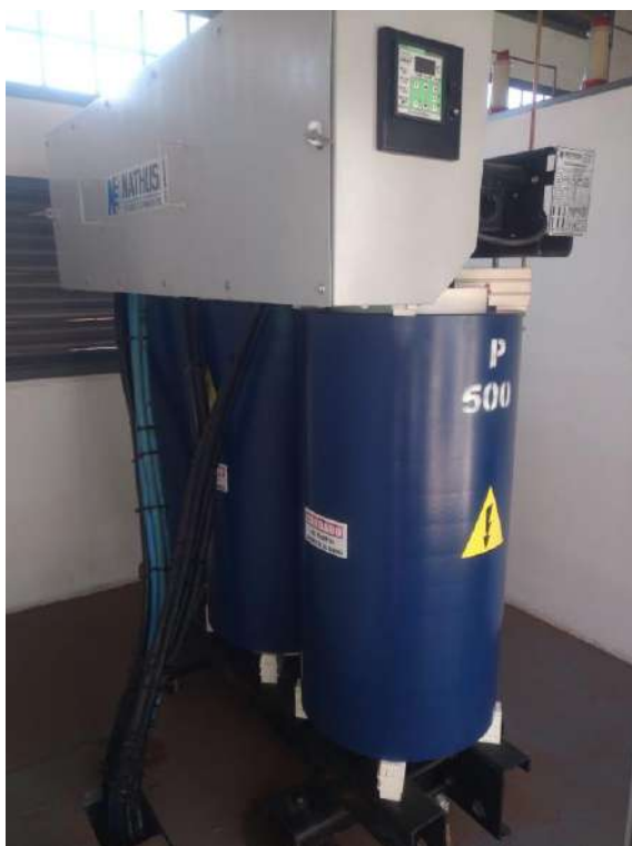
Figura 19: Baia do transformador 500kVA após limpeza e manutenção.
