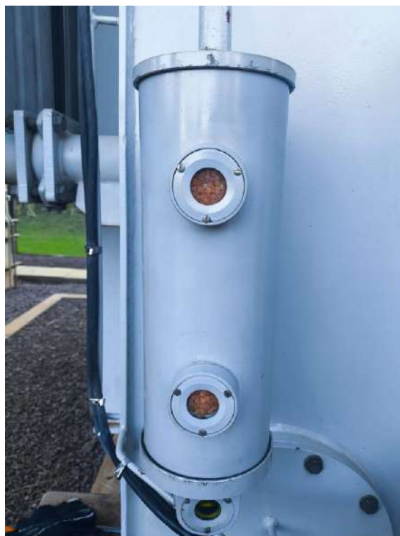
Figura 8: Troca de sílica gel.
