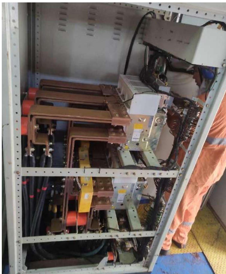
Figura 13: Painel gerador principal após limpeza e manutenção.
