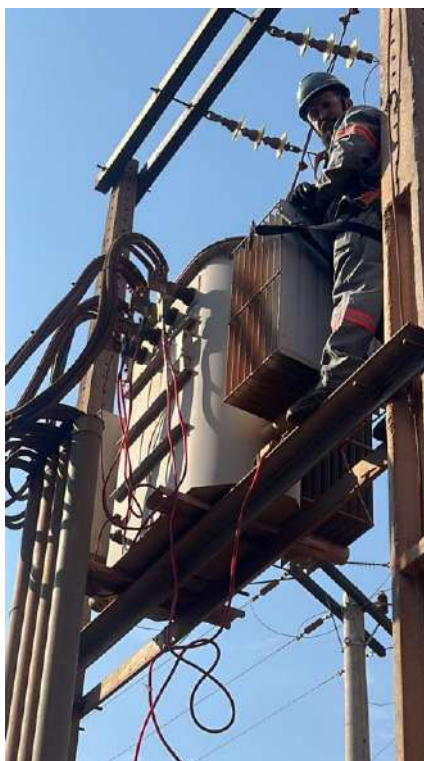
Figura 3: Aterramento temporário, conforme NR10.
