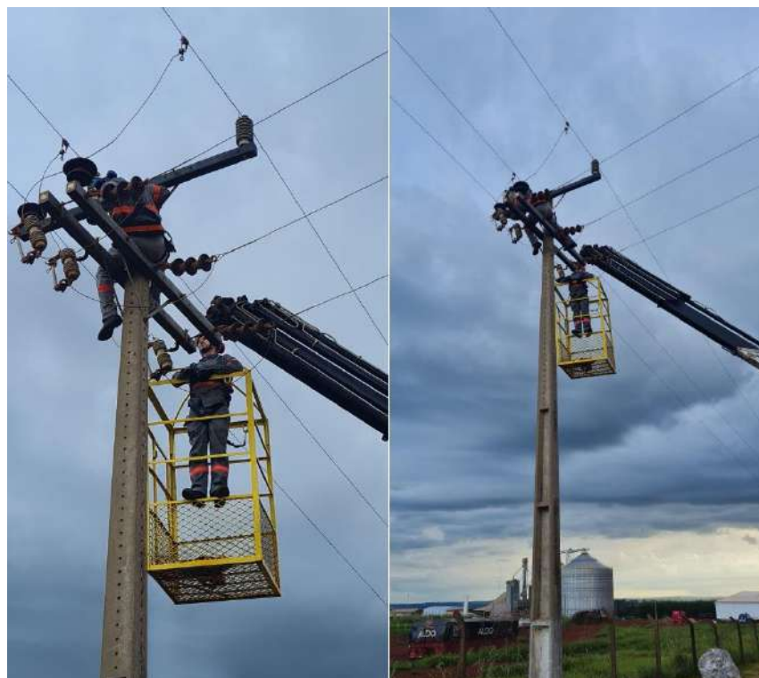
Figura 8: Reaperto em estruturas existentes.
