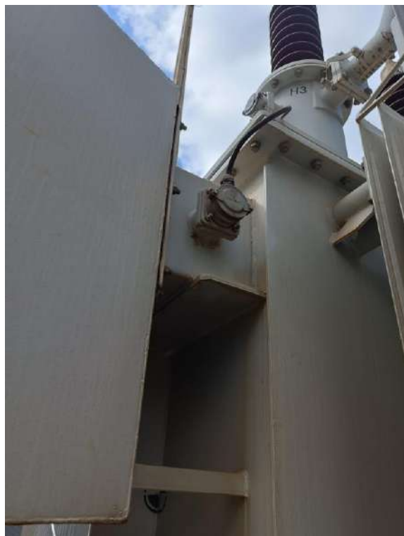
Figura 1: Sensor de temperatura com vazamento (TRAFO WEG).
