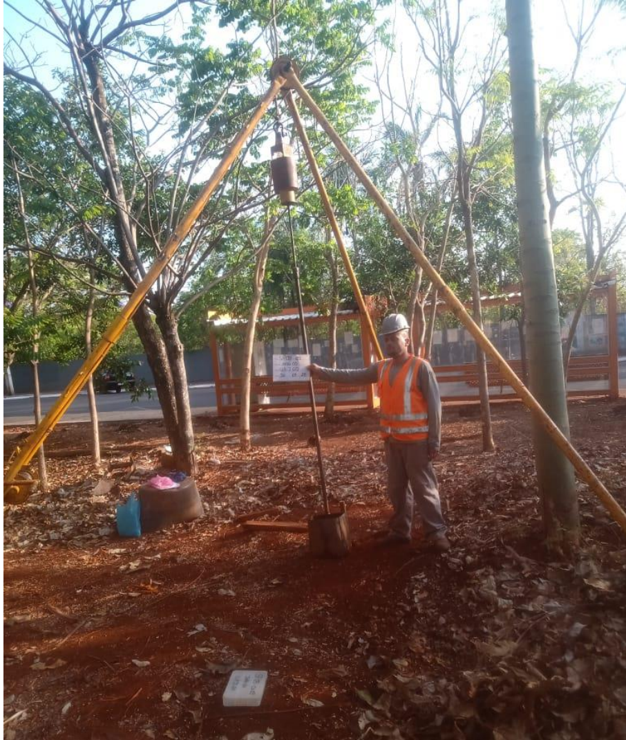
Instalação do furo SP-09
