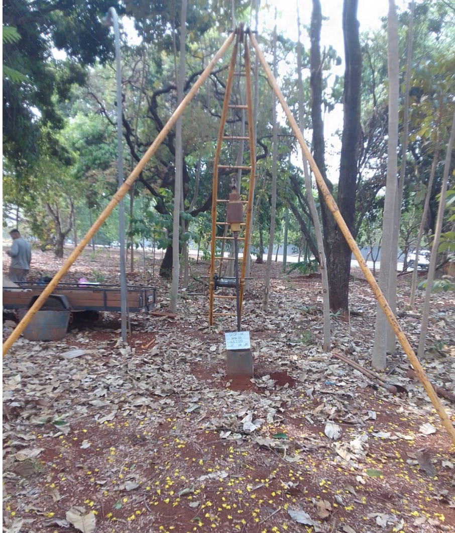
Instalação do furo SP-07
