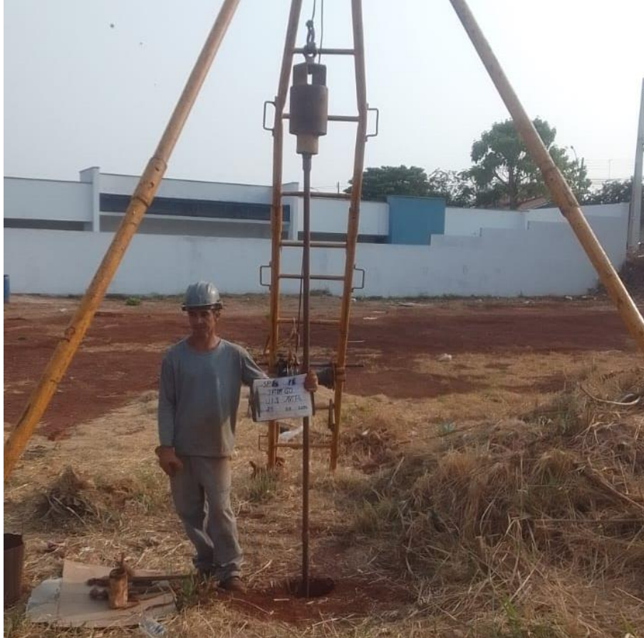
Instalação do furo SP-16
