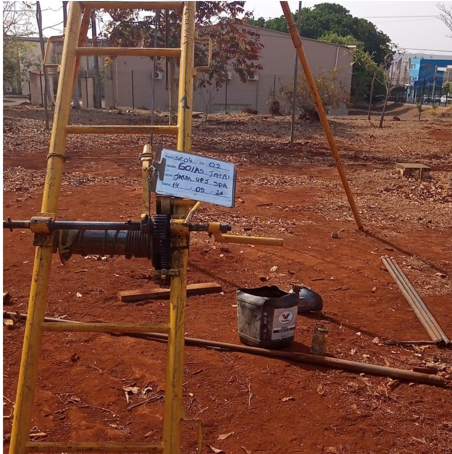
Instalação do furo SP-04
