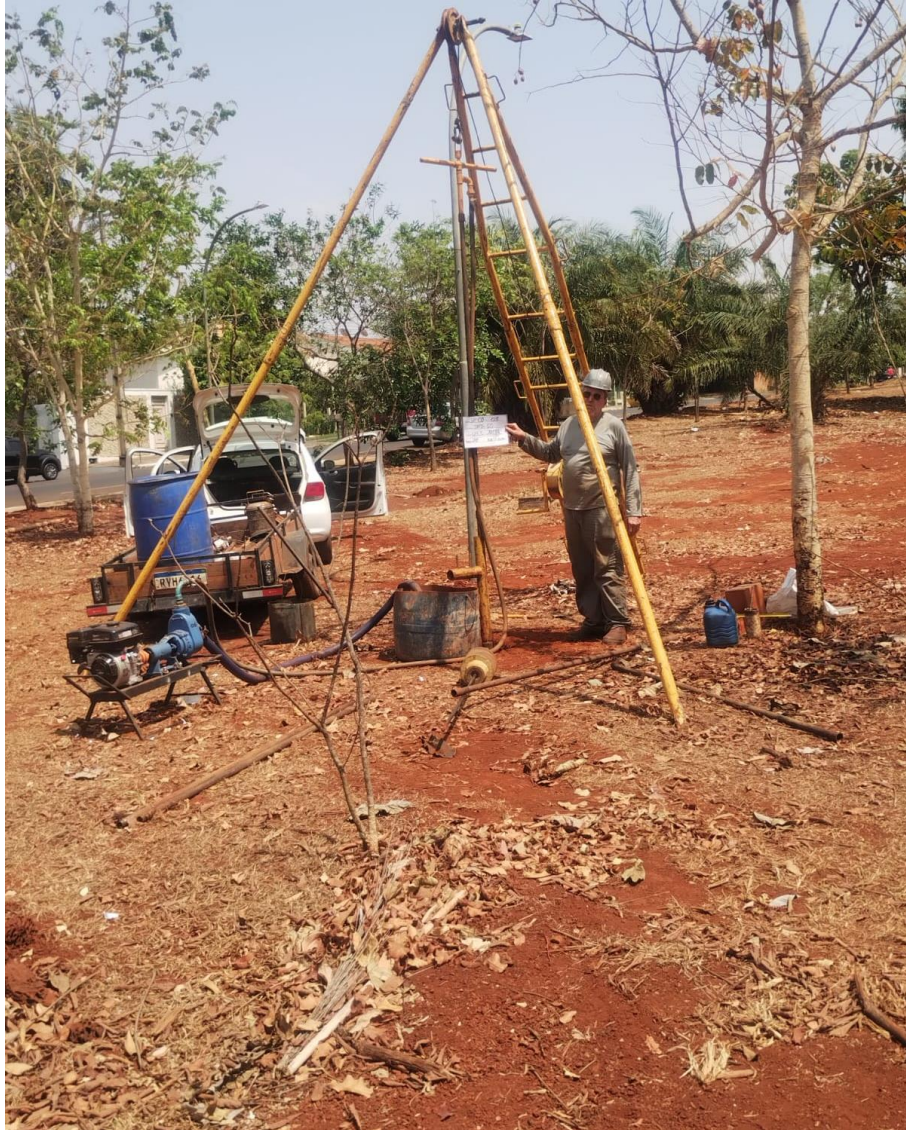
Instalação do furo SP-03
