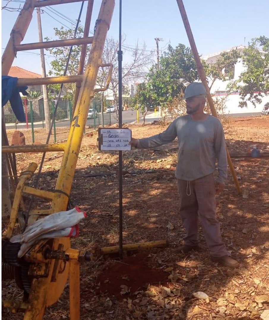
Instalação do furo SP-05
