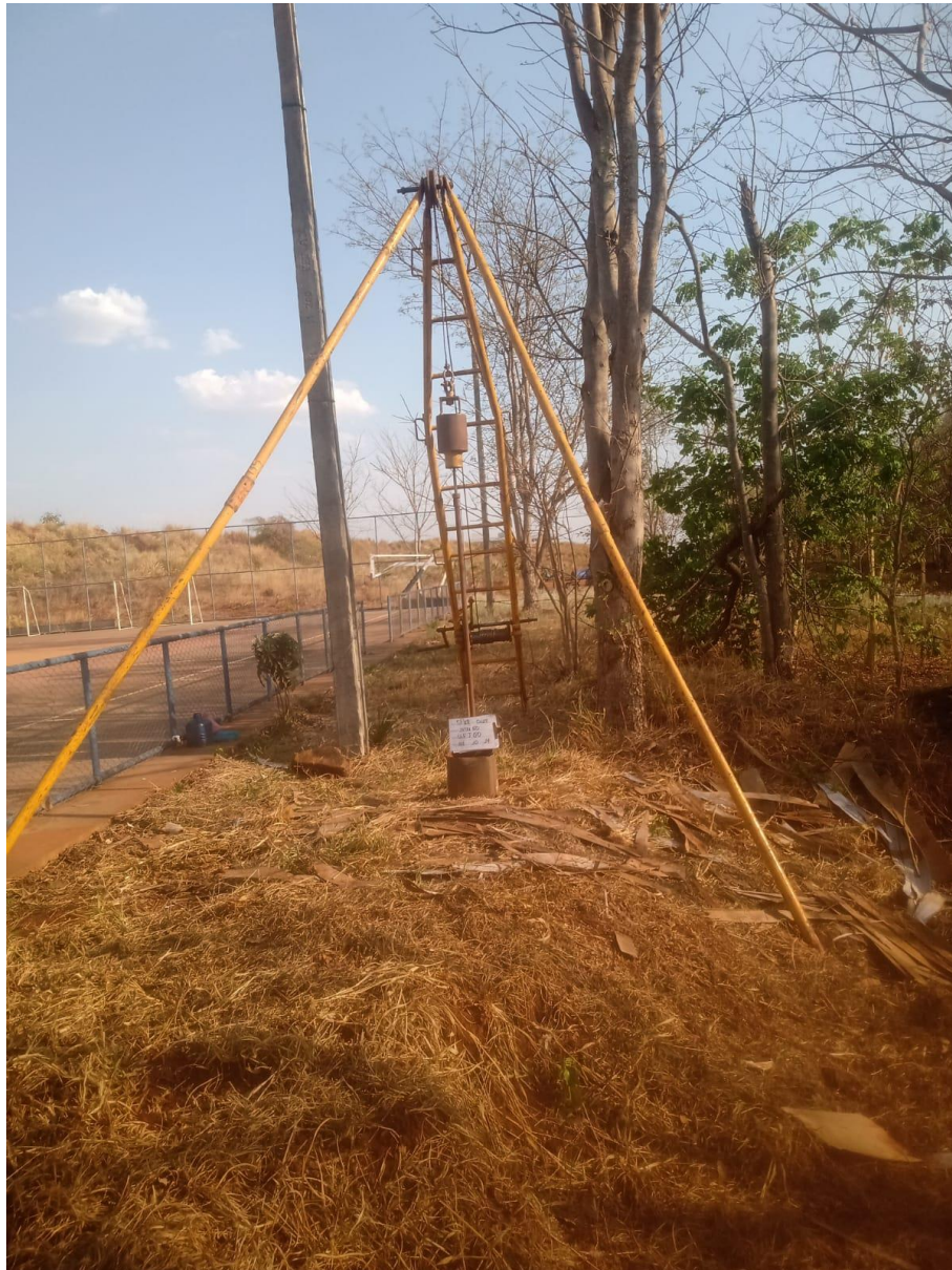
Instalação do furo SP-18
