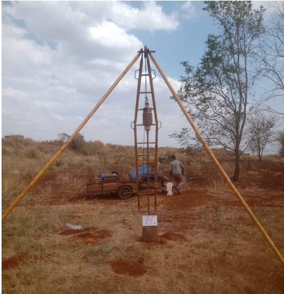
Instalação do furo SP-20
