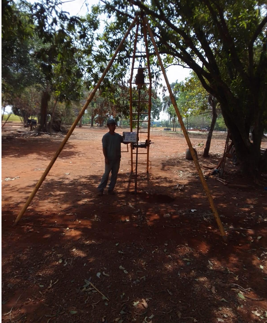
Instalação do furo SP-06
