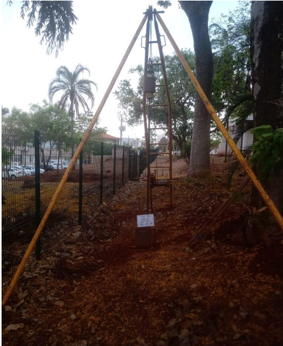
Instalação do furo SP-10
