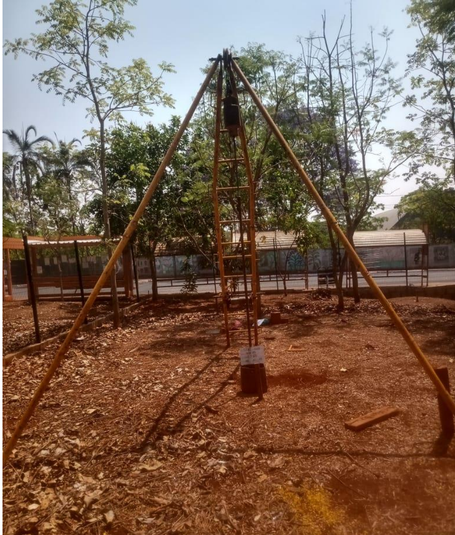
Instalação do furo SP-11
