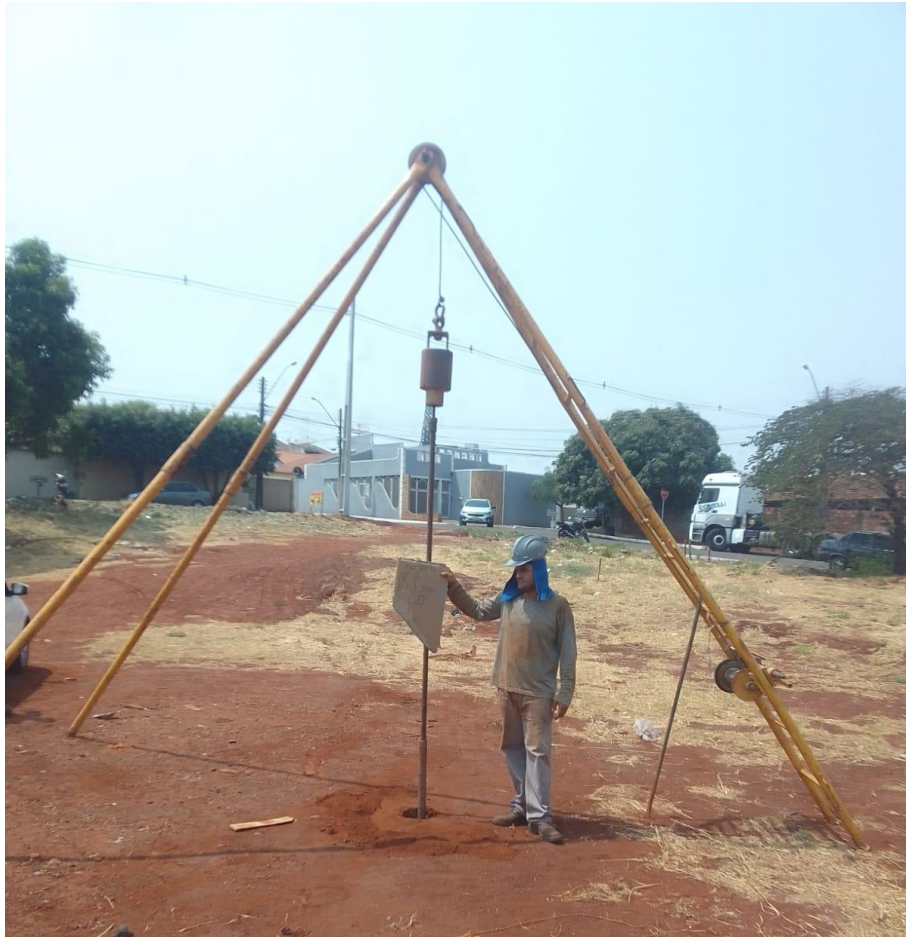
Instalação do furo SP-13
