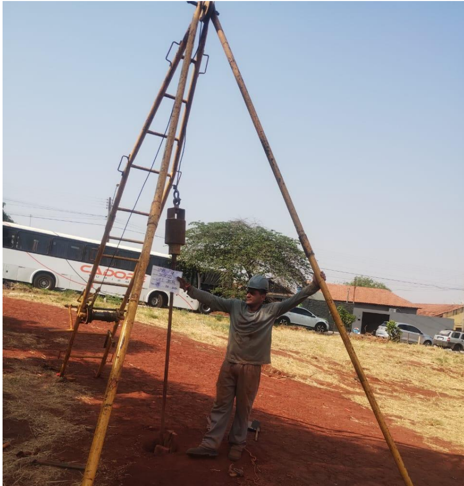
Instalação do furo SP-14
