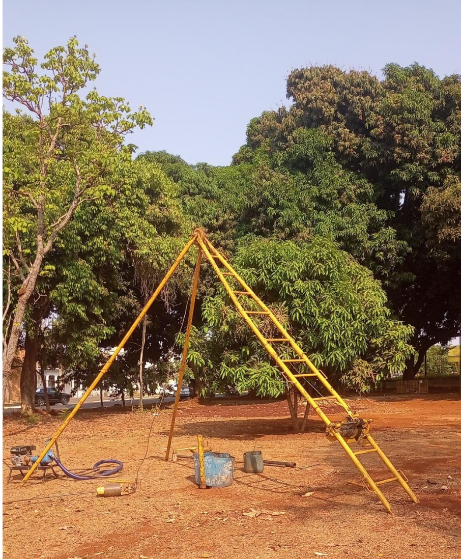
Instalação do furo SP-02
