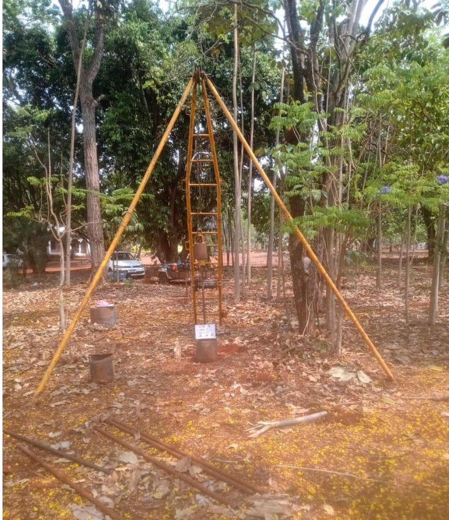
Instalação do furo SP-08
