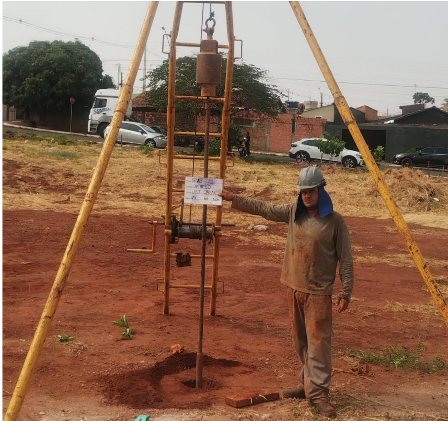
Instalação do furo SP-15
