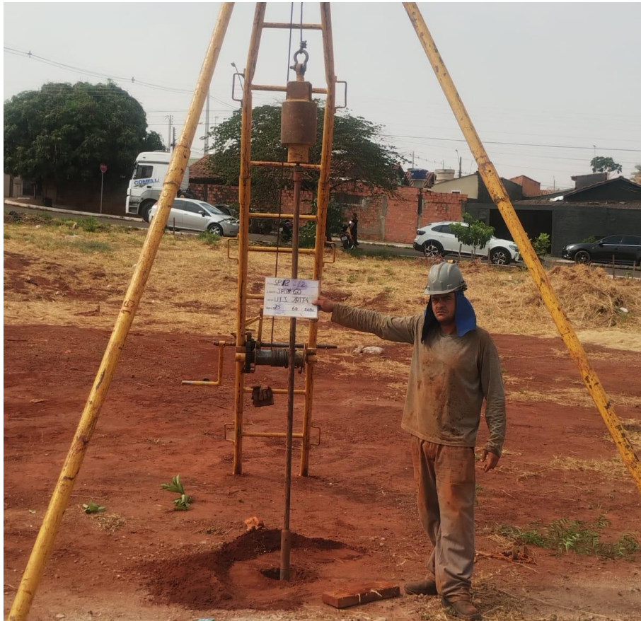
Instalação do furo SP-12
