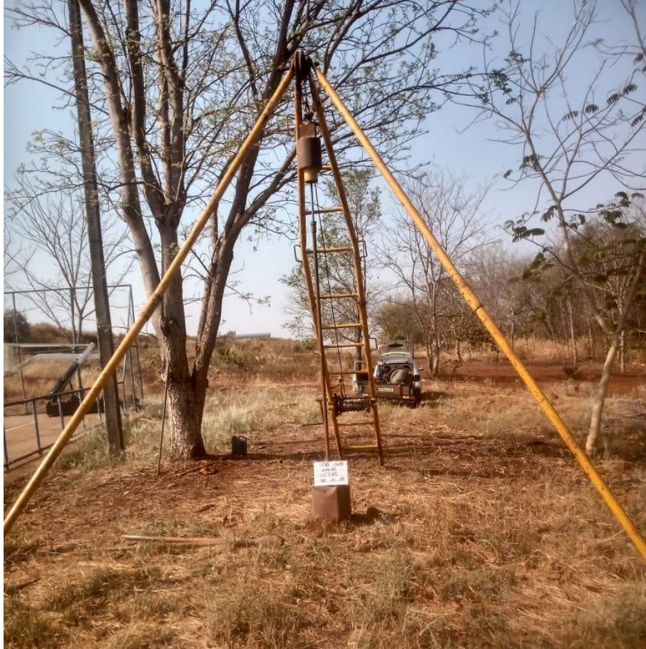
Instalação do furo SP-19
