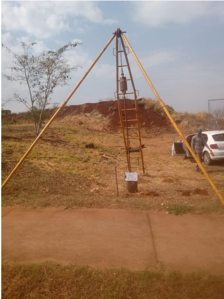
Instalação do furo SP-21
