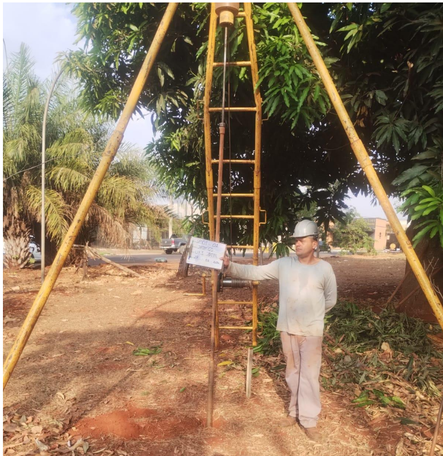
Instalação do furo SP-01
