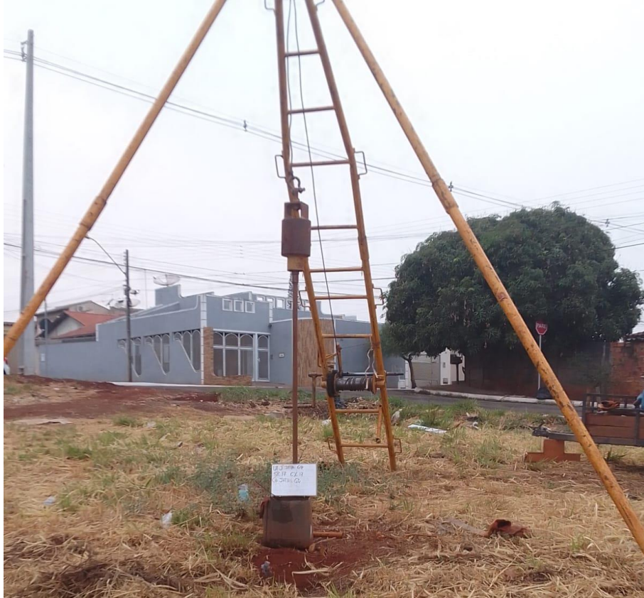
Instalação do furo SP-17
