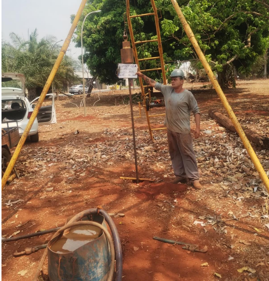
Instalação do furo SP-02 A
