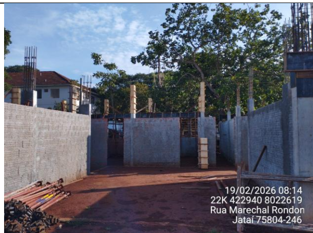
Execução de alvenaria e chapisco
