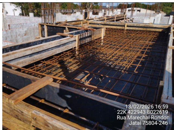
Armadura laje entrada
