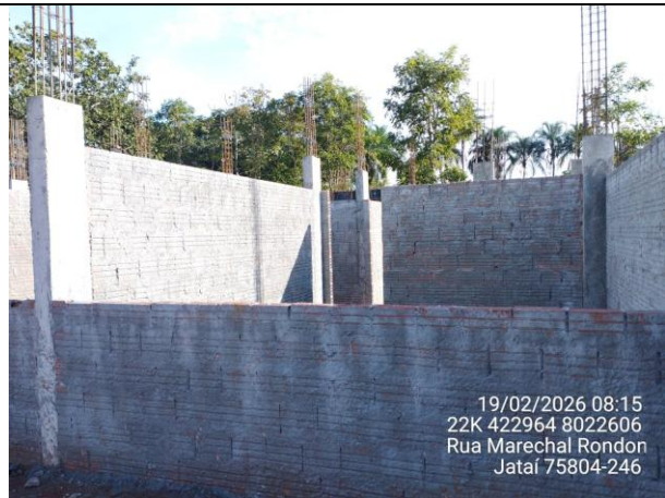
Execução de alvenaria e chapisco
