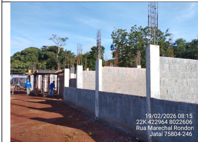
Execução de alvenaria e chapisco
