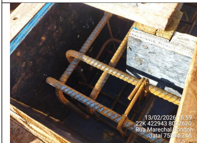
Armadura viga intermediária
