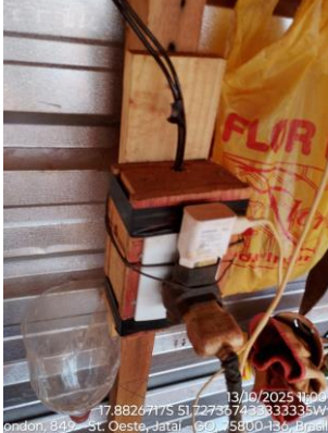
Instalação elétrica fora de conformidade com as nomas de segurança.
