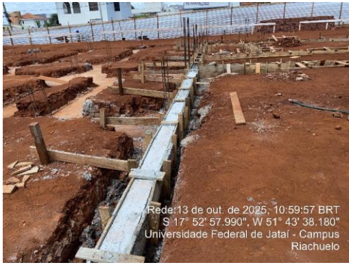
Detalhe da viga baldrame concretada IN LOCO
