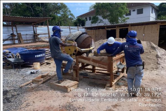
Detalhe do concreto sendo rodado IN LOCO com betoneira
