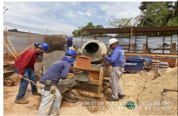
Detalhe do concreto sendo rodado IN LOCO com betoneira
