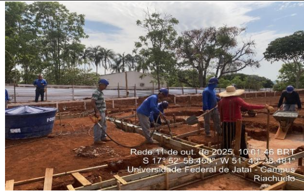
Detalhe da execução da concretagem da viga baldrame IN LOCO
