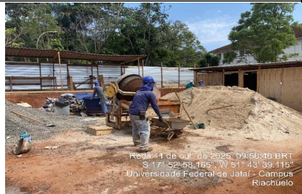
Detalhe do concreto sendo rodado IN LOCO com betoneira
