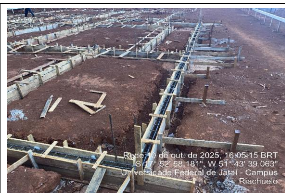
Detalhe das vigas baldrame
