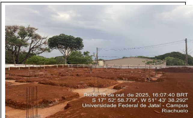
Detalhe das vigas baldrame
