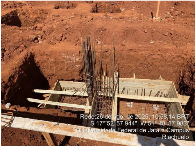
Sapata sem concreto
