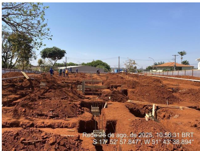
Vista geral da obra
