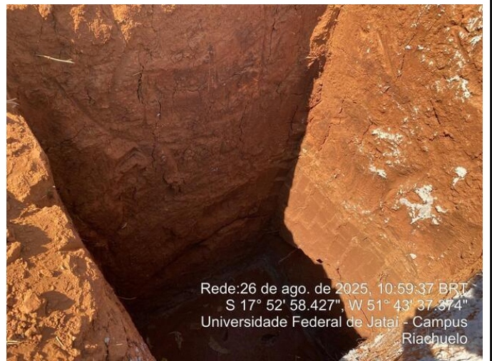
Vala da sapata sem forma
