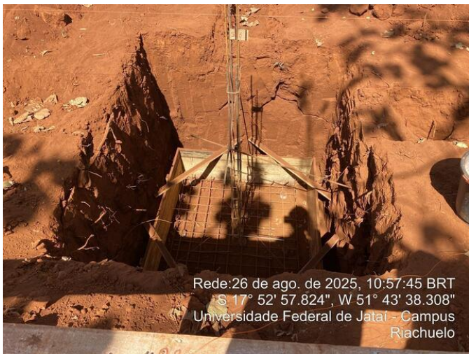
Sapata sem concreto
