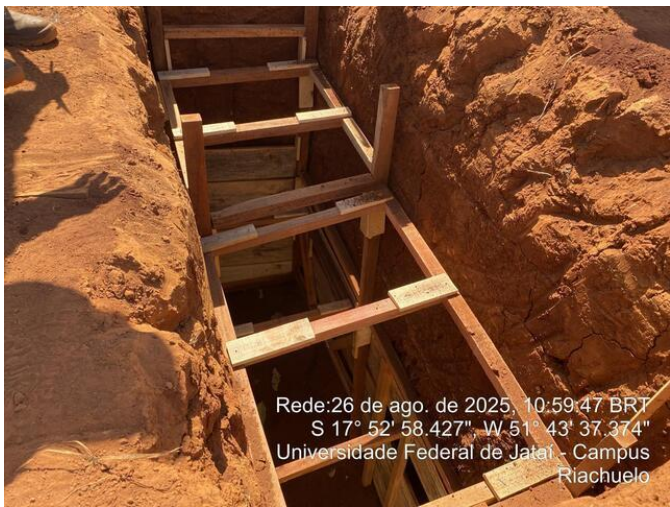
Sapata sem concreto
