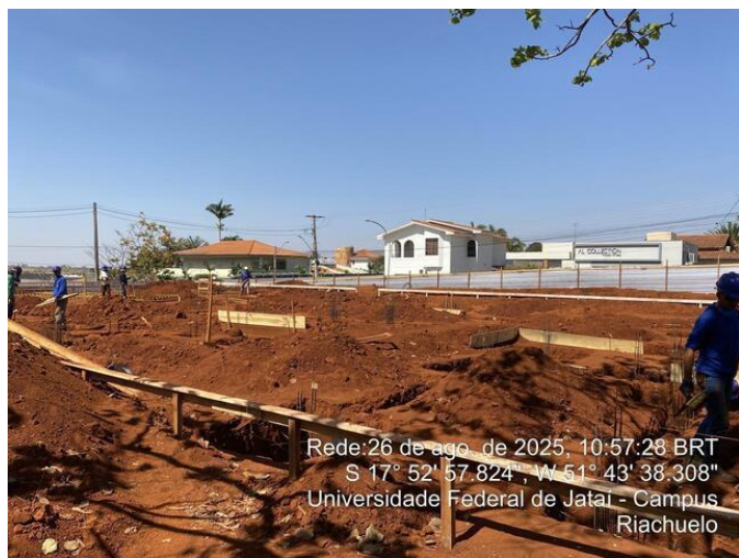
Vista geral da obra
