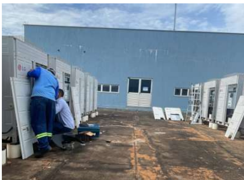
Manutenção em Condensadoras
