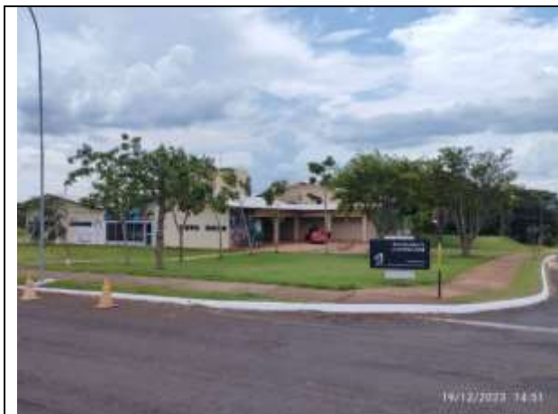
Figura 1 – Vista externa RU
