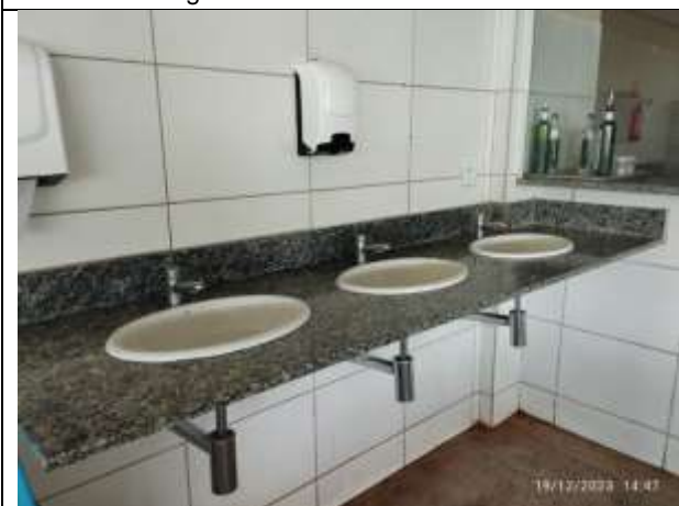
Figura 47 – Lavatórios área refeição
