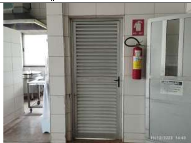
Figura 36 – extintor interno
