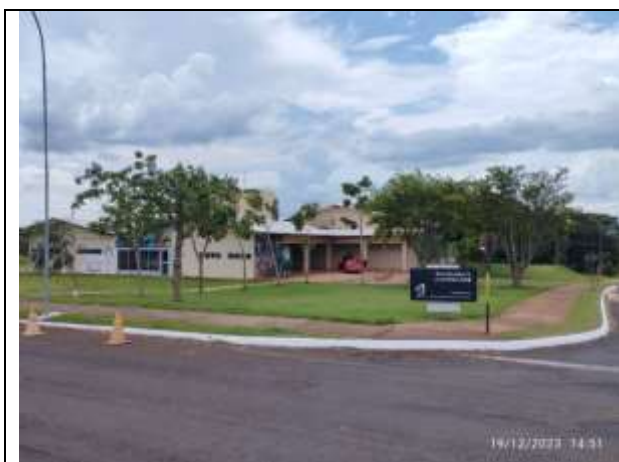
Figura 1 – Vista externa RU
