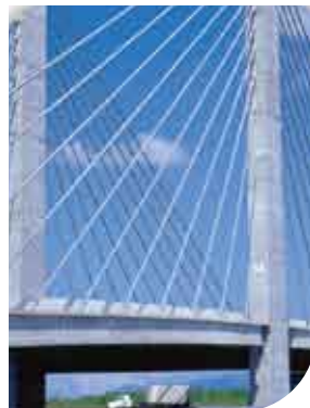
Utilização de Cordoalha Estaiada na Rodovia Imigrantes - SP
