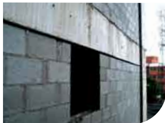
Região de interface estrutura/alvenaria
