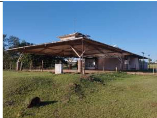
Figura 1 – Vista externa Cantina
