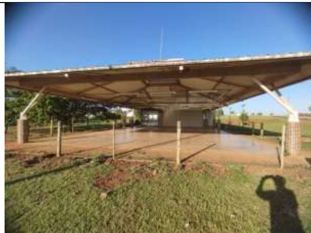
Figura 2 – Vista externa Cantina
