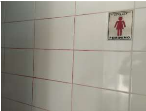
Figura 9 – Revestimento Banheiro Feminino
