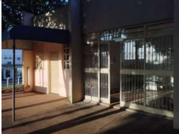
Figura 1 – Vista externa Cantina
