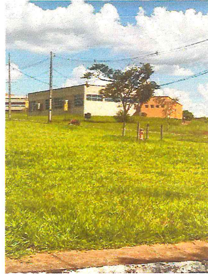
Fig.10 – Vista área externa 02
