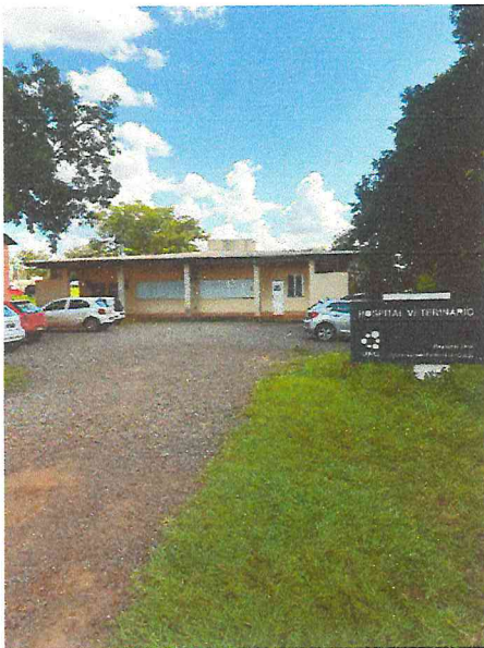
Fig.07 – Setor Hospital Veterinário visão interna.
